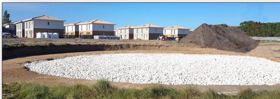
Près du lotissement, vue du silo de sondes qui est aujourd'hui recouvert par l'énorme tas de terre entreposé sur la droite de l'image, rendant cet équipement invisible (photo dossier).
