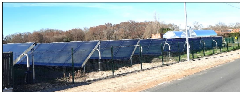
Vue d'une partie des 236 panneaux solaires et des cuves de stockage journalier (photo CE)
